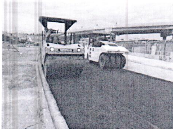
Imagem 2: Obra do Grupo Enpavi em Jandira-SP
